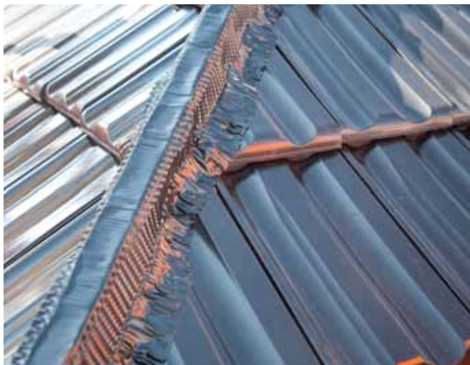
Ugrađena sljemeno-grebena traka
