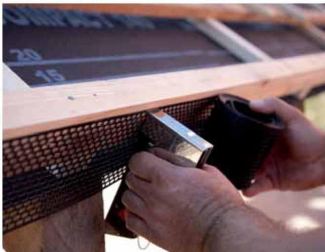
Postavljanje perforirane trake za provjetranje
