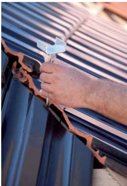
Postavljanje sljemeno-grebene letve
